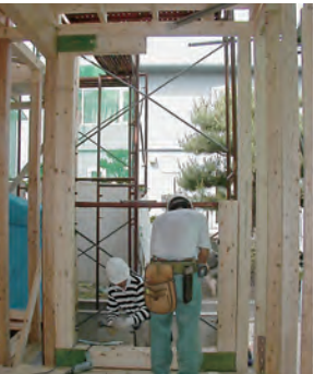
BOX型フレーム設置状況
