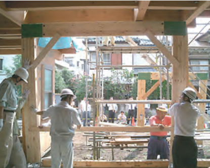
門型フレーム設置状況
