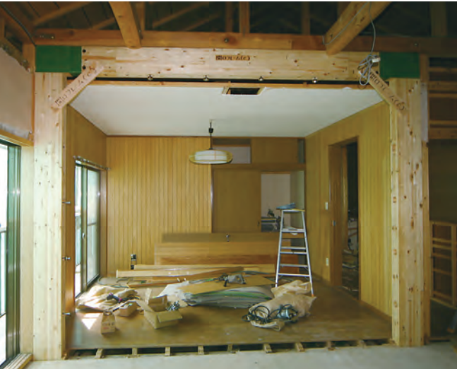
▲門型フレーム 玄関入り口に設置
