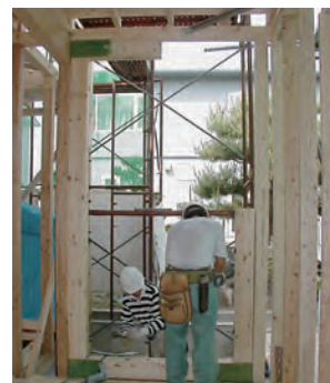
BOX型フレーム設置状況
