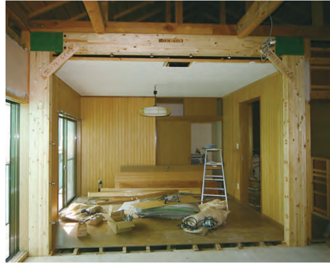
▲門型フレーム 玄関入り口に設置
