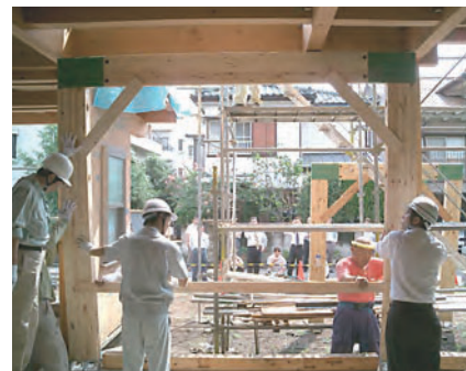
門型フレーム設置状況
