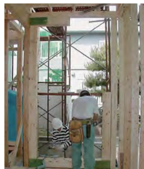
BOX型フレーム設置状況
