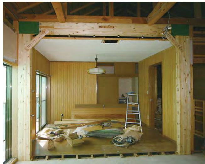
▲門型フレーム 玄関入り口に設置
