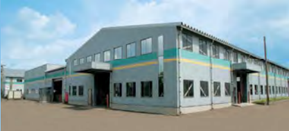
金属工場(プレス・板金・溶接第一)
