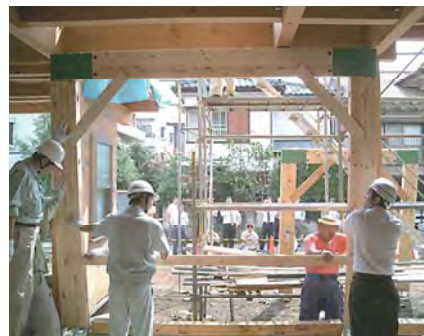
門型フレーム設置状況
