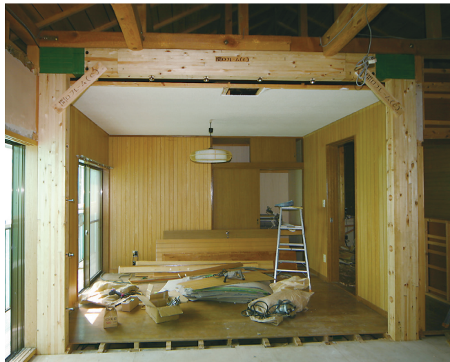
▲門型フレーム 玄関入り口に設置
