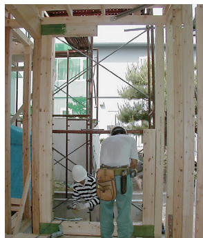
BOX型フレーム設置状況
