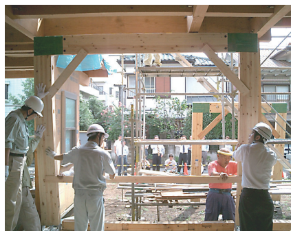
門型フレーム設置状況
